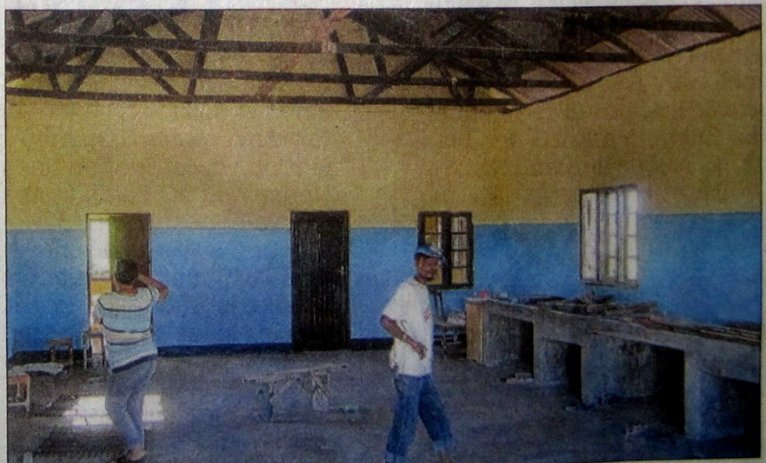
Der Umbau der einstigen Fischhalle in Mikocheni in eine Schule nimmt immer mehr Gestalt an.
